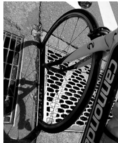
ロードバイクの細いタイヤがすっぽりハマる、交差点のグレーチングに出来た隙間
